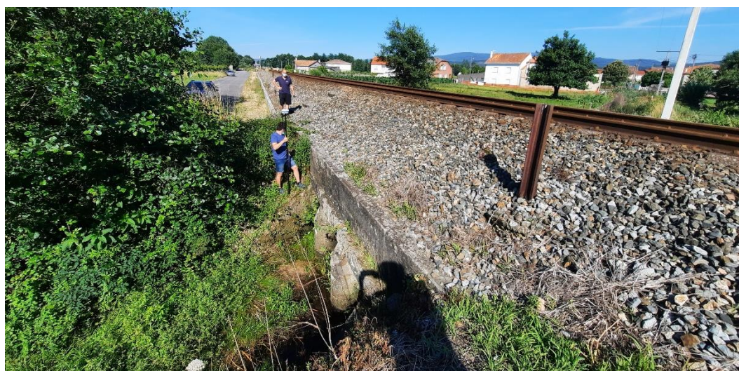
Figura 8. ODT bajo la vía de FFCC. Estructura sobre el cauce del Río Soutiño. Fuente: Aquatica.
