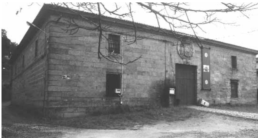
Edificio das rentas do tabaco
